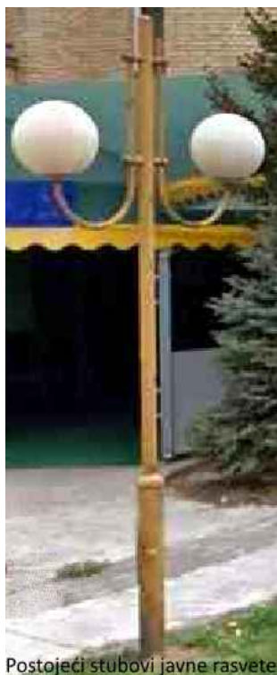
Postojeći stubovi javne rasvete
