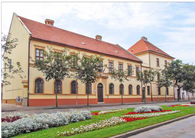
Здање Паула Крушпера (данас Историјски архив у Сомбору)
