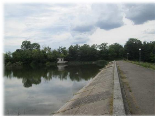
Слика 15: Земљана брана са афсалтираом круном на акумулацији Панонија
